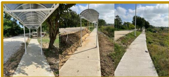
Con una inversión de \$1,868,917.89 se hicieron trabajos de arreglo del camino de acceso conformando la base hidráulica a base de revestimiento con grava, así como el mantenimiento de banquetas y de estructuras metálicas con policarbonato celular para el paso de transeúntes.
