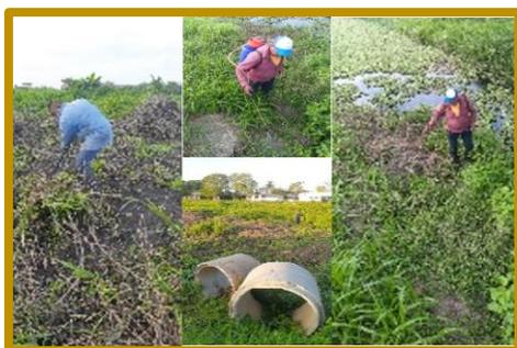
Para garantizar en todo momento el control sobre inundaciones en terrenos del ITSM, ante la presencia de lluvias atípicas en los meses de mayo y junio, se realiza la limpieza permanente en los drenes de aguas pluviales y aguas servidas que atraviesan las instalaciones del ITSM, evitando y controlando también la proliferación de fauna nociva, así como flora invasiva en esta zona, y con el objetivo de forestar para el crecimiento de las áreas de sombra dentro de la institución.
