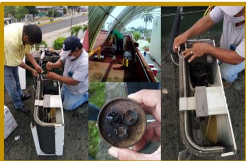
Se limpiaron motores y evaporadoras de los aires acondicionados de los cuatro edificios del ITSM, recarga de gas, cambio de piezas, verificación de voltajes.
